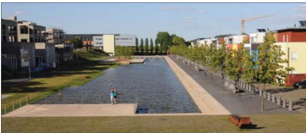
Fig. 8: Retentionsanlage Wasserband – Petrisberg
