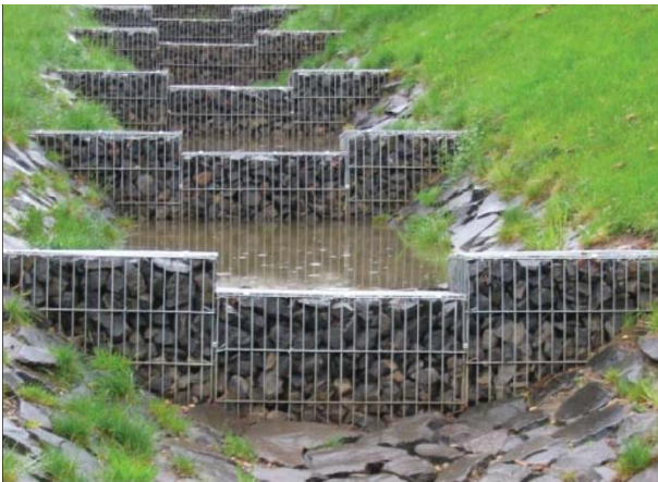
Fig. 9: Kaskaden-Rückhaltesystem auf dem Petrisberg – der Wasserweg Verbindungsglied zwischen Wasserband und nachgeschalteten Versickerungsterrassen (Fig. 8 u. Fig. 11)
